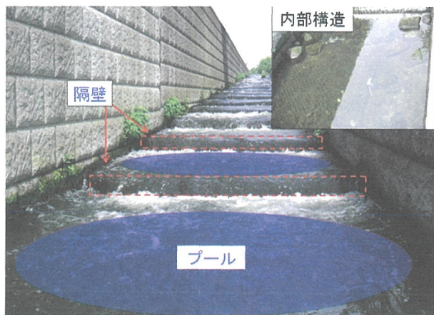
図1 階段型魚道の構造
