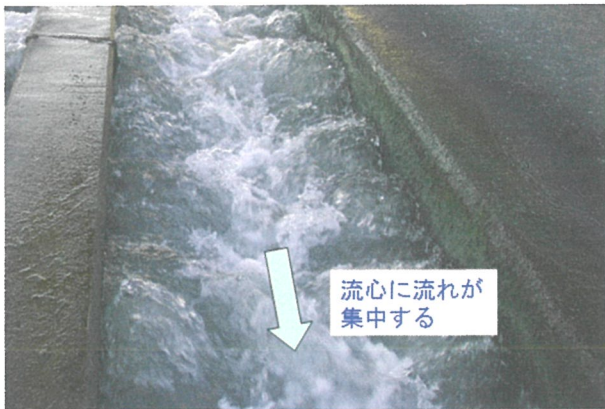
図4 デニール型魚道の構造
