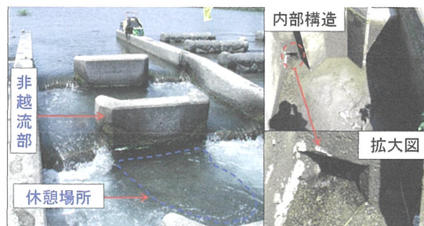
図3 アイスハーバー型魚道の構造
