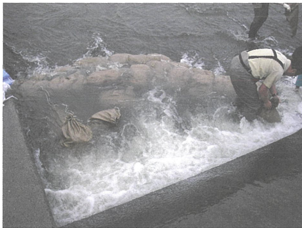
写真2 土嚢積み上げ作業
